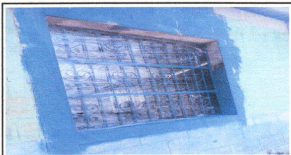
Foto 3: Cambio de las cuatro ventanas.
